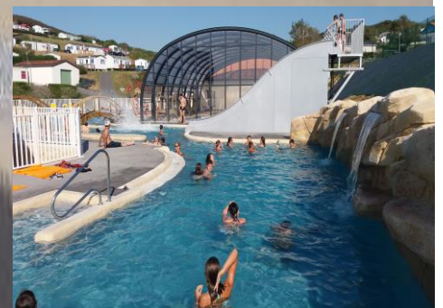
Espace Aqualudique chauffé
